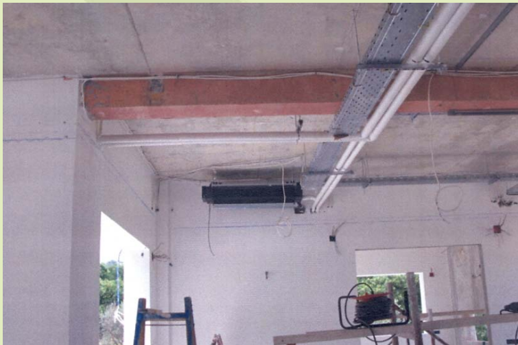
Fan Coil (Cooling system)
